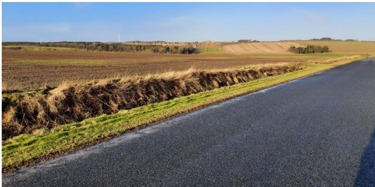
Figur 6 - Besigtigelsesbillede S2, Ullerupvej 14/12. det ansøgte vurderes ikke at ville fremstå markant i landskabet og vil fremstå med landskab og tekniske anlæg som baggrund.
